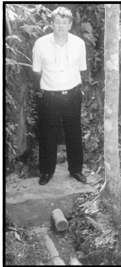
Local de captação
