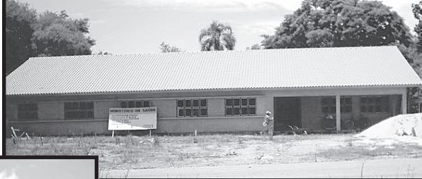
Prédio da Unidade Mista de Saúde
