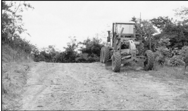
Máquina trabalhando nas estradas do município
