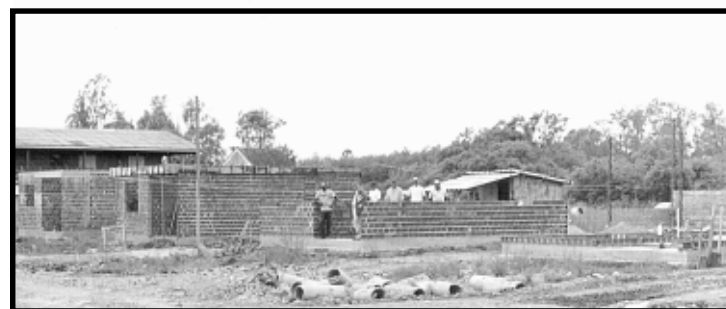
Obras de construção das casas da Brigada e Civil, executadas pela Prefeitura Municipal
