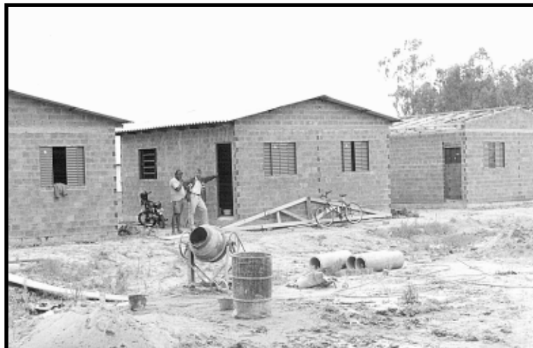
Sec. de Obras Erni conferindo a construção juntamente com o responsável pela obra
