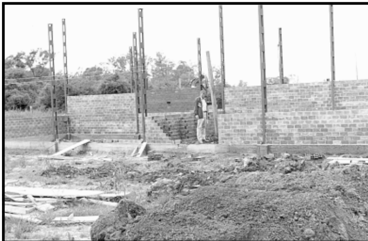
Na foto: Fase inicial da construção
