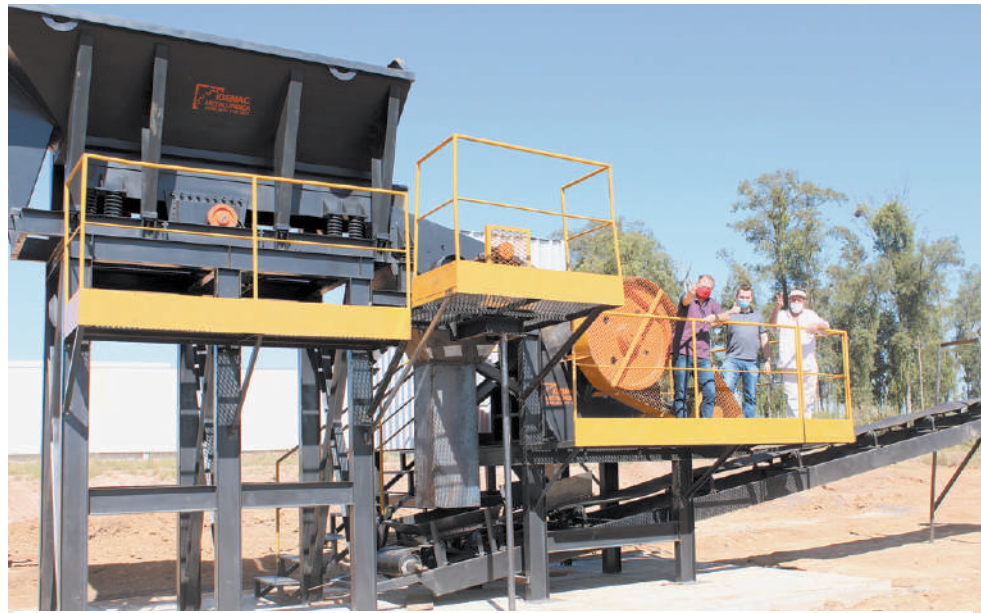
Britador foi instalado no Distrito Industrial do Município e aguarda a instalação da rede elétrica e rampa de acesso para entrar em funcionamento.
